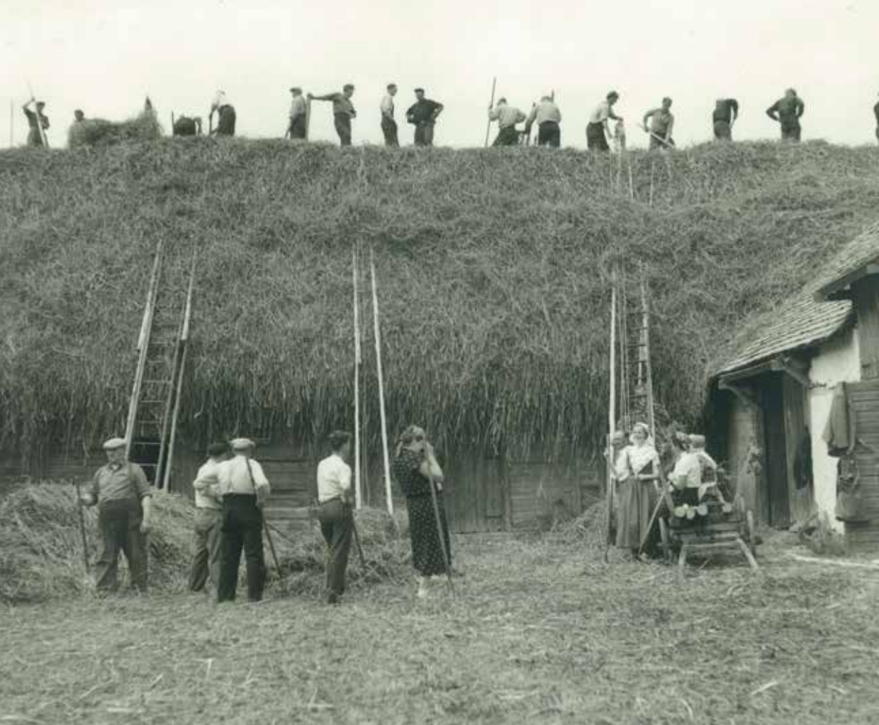
Det gamla taket revs för att ersättas av öns största agtak. Fårös taktäckare såg till att göra ett bra jobb 1954. Fotograf okänd.
